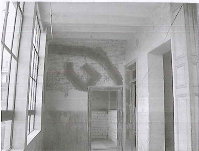
Fig. 42 y 43 – Refuerzo de muros transversales
