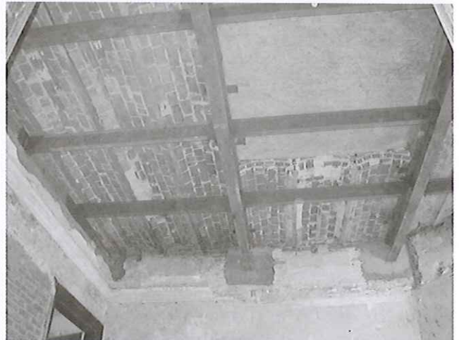
Fig. 10 y 11 – Apuntalamiento y refuerzo en sub-suelo
