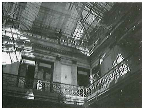
Fig.1 Antes de la Intervención
