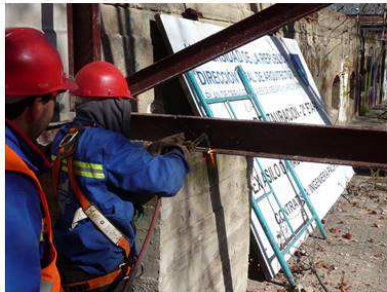
Julio de 2012: retiro progresivo de apuntalamiento. Corte del acero para separarlo de las bases de hormigón.
