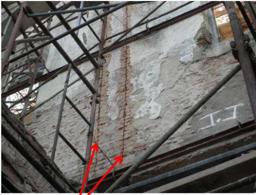
Marcado y corte con disco
