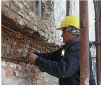
2 - Limpieza del polvo con aire comprimido
