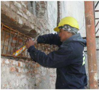
3 - Inyección de mortero de anclaje
