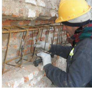
4 - Colocación de varillas
