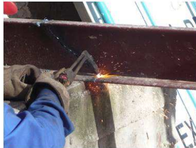
Julio de 2012: retiro progresivo de apuntalamiento. Corte del acero para separarlo de las bases de hormigón.
