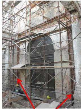
Zanjeado para estructura
