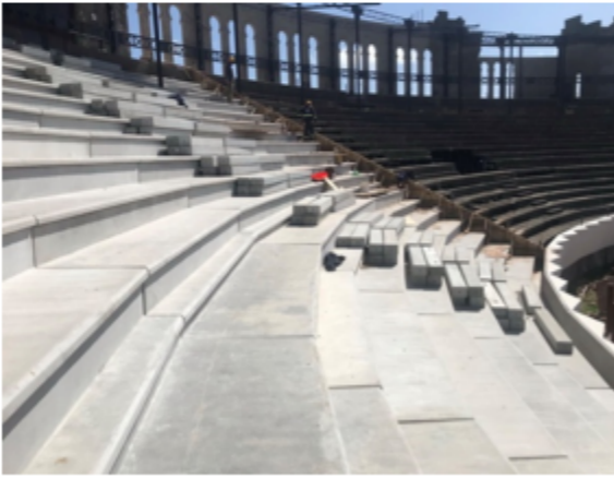
Ensayo de Carga sobre gradas
