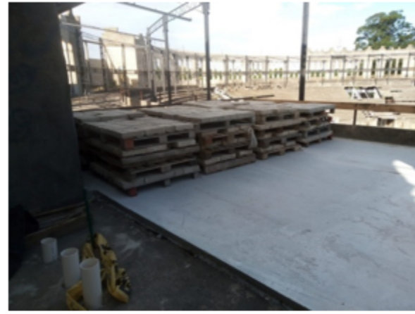
Ensayo de Carga sobre losa nueva
