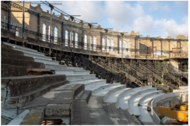
Gradas prefabricadas nuevas
